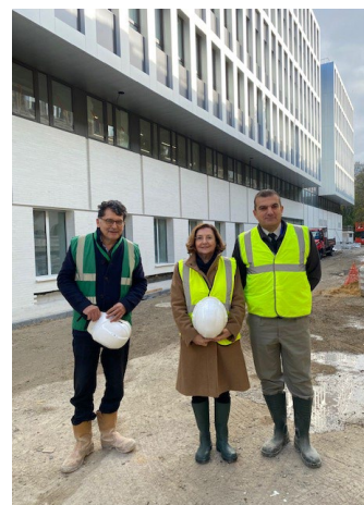
Visite de chantier du siège de la DRSD au Fort de Vanves
